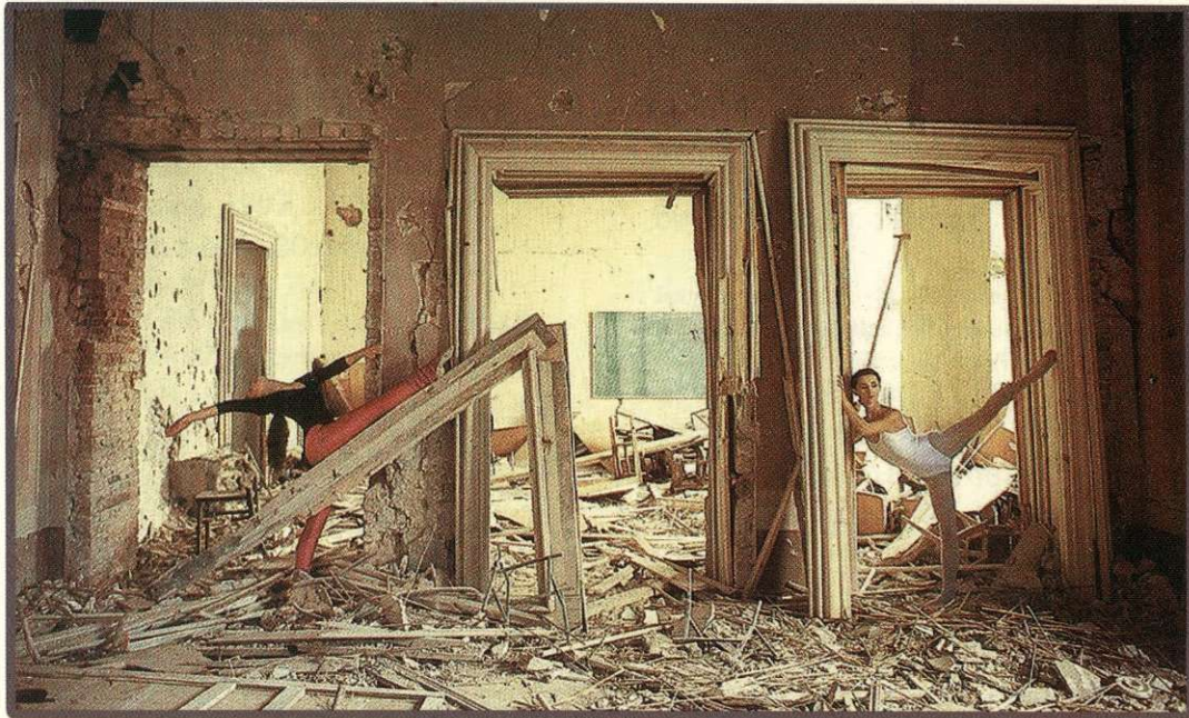
Providurova palača, baletna škola, foto: Željko Karavida
